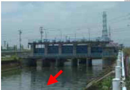
①:0K566信濃川樋門
